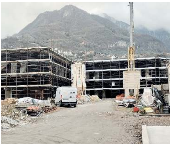
Il cantiere. Qui sta sorgendo il polo scolastico di via Borgonuovo
